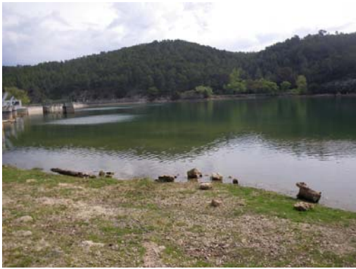
▲ Vue de la zone de prélèvements depuis la rive gauche au droit du point o3
