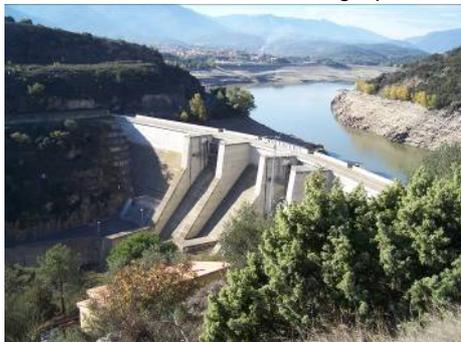
Le second, situé plus à l'aval, mis en eau en 1974, coupe très nettement le bassin en deux parties. Il a une double fonction d'écrêtement des crues et de soutien d'étiage, avec un volume de régulation disponible de **24 Mm<sup>3</sup>**.
