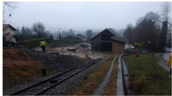
*Obstruction du franchissement depuis l'amont et l'aval des rails du funiculaire ayant conduit aux divagations rive gauche et rive droite ; engravements de la gare du Funiculaire et obstruction du pont de la RD 1 090 (source : ONF-RTM, photographies extraites du rapport Communes du Plateau des Petites Roches, Crolles et Lumbin – site de Montfort – Avis suite à une crue torrentielle en date du 29/12/2021 de l'agence RTM Alpes du Nord / Service départemental RTM de l'Isère du 10/01/2022)*
