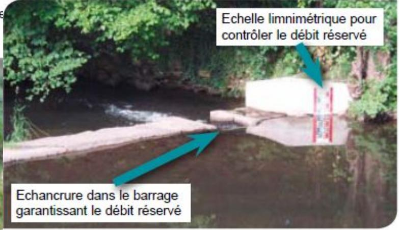
Echelle limnimétrique pour contrôler le débit réservé
